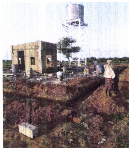
Photo 9: Mini AEP en cours de réalisation à Dan Hayi-Malbaza
